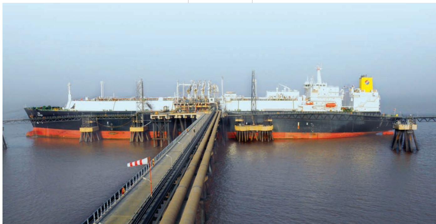
LNG Ship berthed at Dahej LNG Terminal
